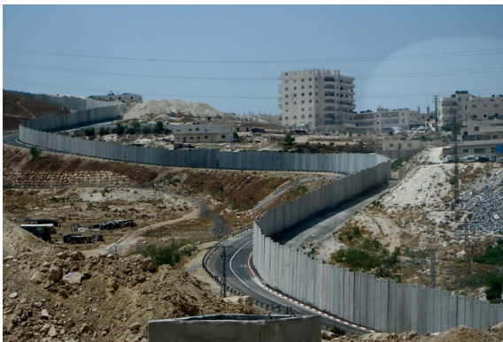
Figura 5: Muro de concreto em Jerusalém
